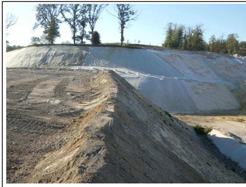
Aménagement des casiers (septembre 2023).
