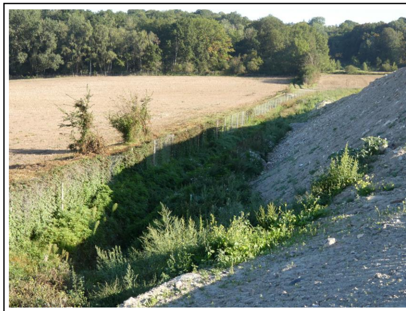
Réseau de fossés périphériques (septembre 2023).
