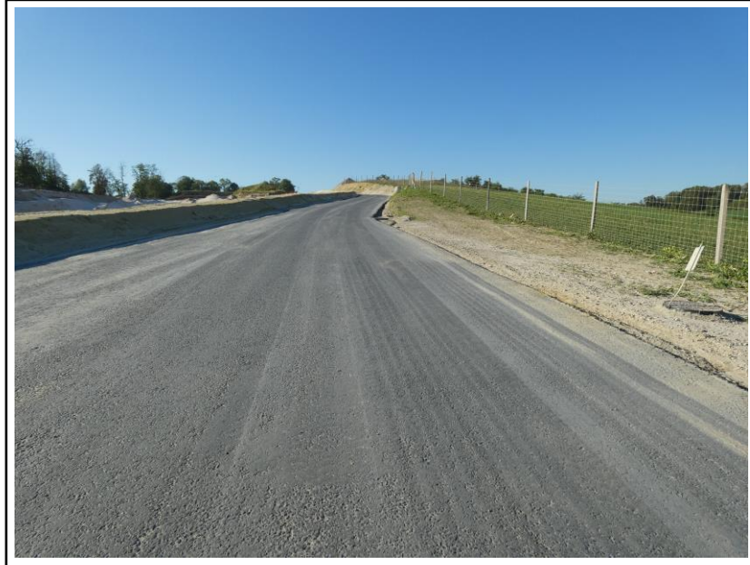
Nouvelle piste interne revêtue en enrobé (septembre 2023).
